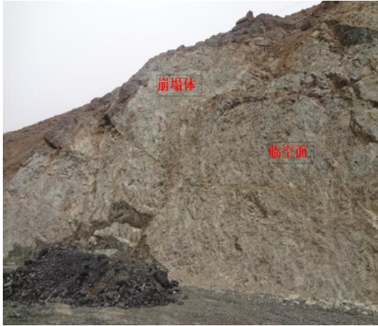
B1 崩塌隐患点
