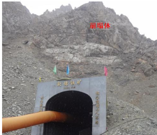
B3 崩塌隐患点
