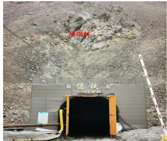
B2 崩塌隐患点
